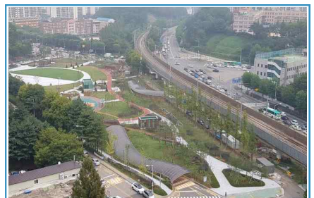
지하저류조(군포 양지공원) : 지하(저류+주차장), 지상(공원)
