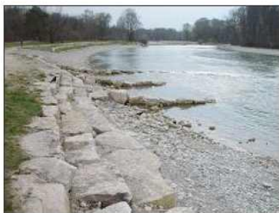
(1) 거석 및 수제 설치
