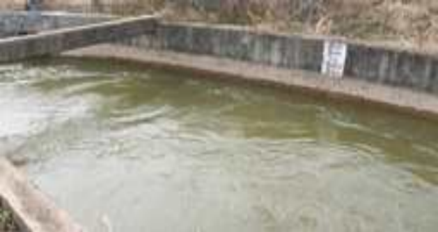
【 취수보를 이용한 자연(중력)유하 방식 】
