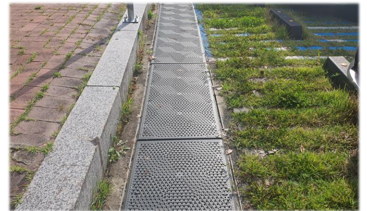
배수로 정비·신설 / 덮개 설치
