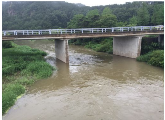
[주천관측소 하류 전경(홍수기)]
