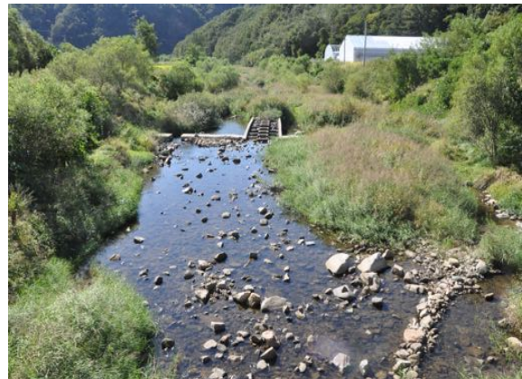
[양악 수위관측소 하류 전경(평·갈수기)]
