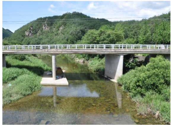
[주천관측소 하류 전경(평·갈수기)]
