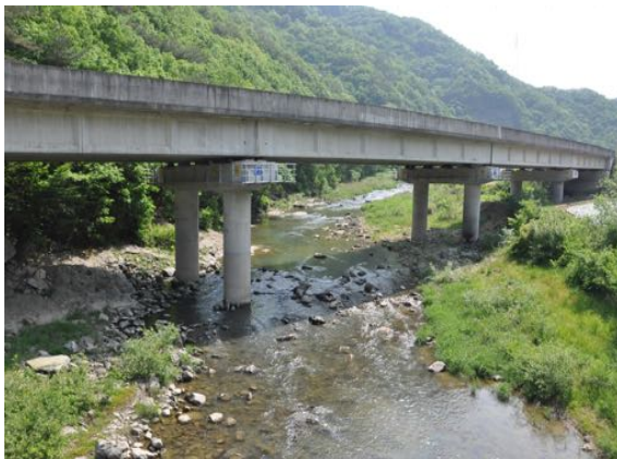
[석정 수위관측소 상류 전경(평·갈수기)]
