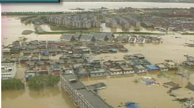
강동구 풍납동 침수피해(3일간 334.4mm)
